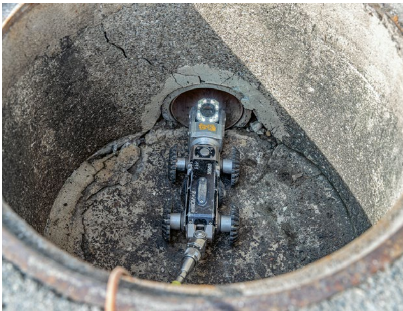
Kanal-TV-Roboter im Einsatz
