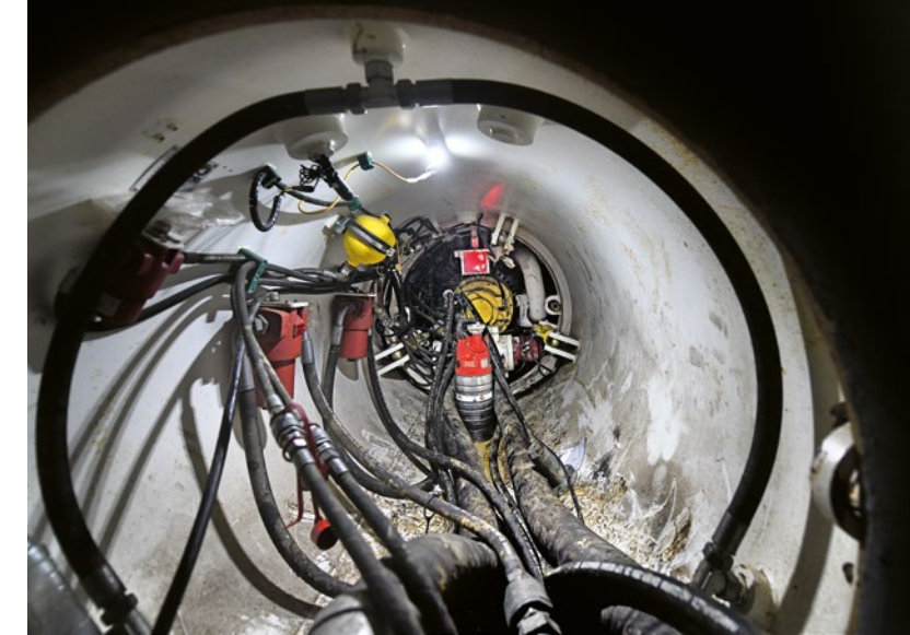
Blick ins Innere eines Microtunneling-Vortriebs
