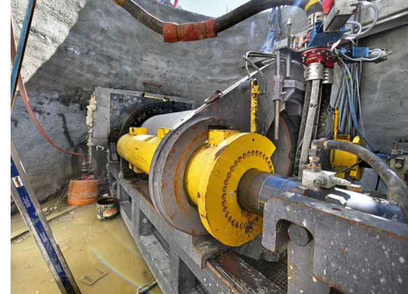
Pressstation eines Microtunnelings
