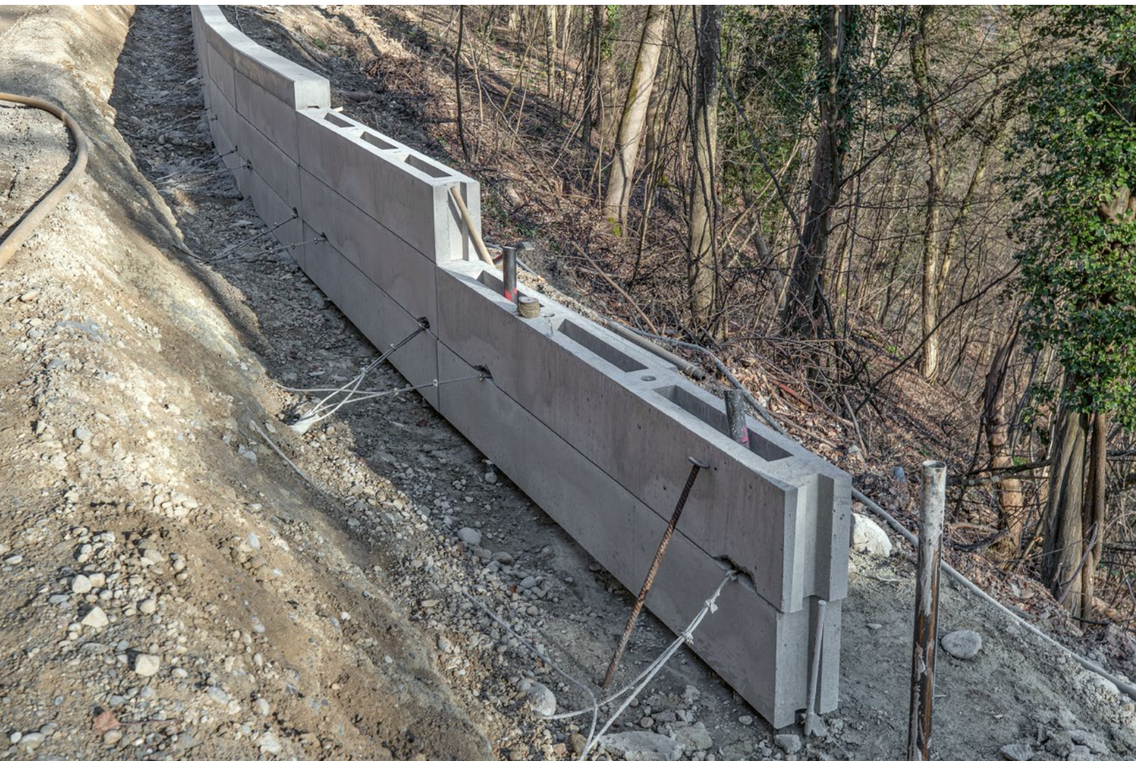
Versetzen von Elementplatten
