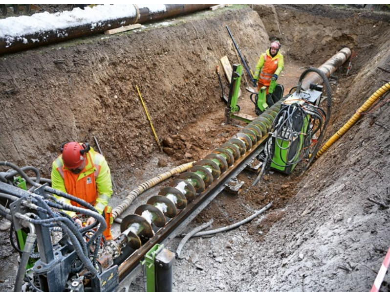
Installation einer Imlochbohrung
