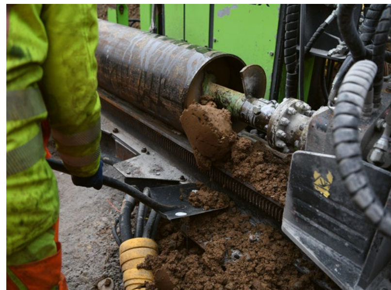
Materialauswurf bei einer Imlochbohrung
