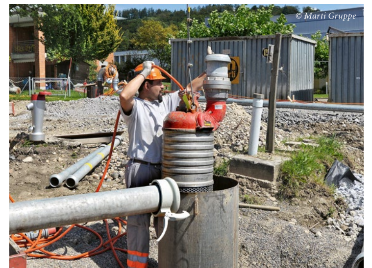
Einsetzen der Pumpe in einem Filterbrunnen
