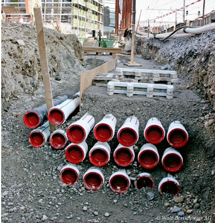
Trennung eines Elektro- und Telekommunikations-Rohrblocks mit einer Holzfaserverplatte
