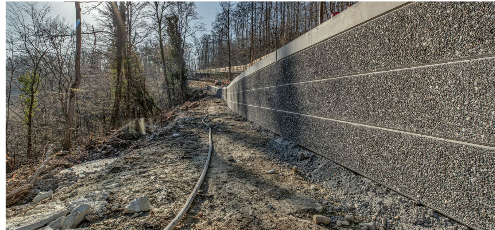
Fertig versetzte Elementplatten
