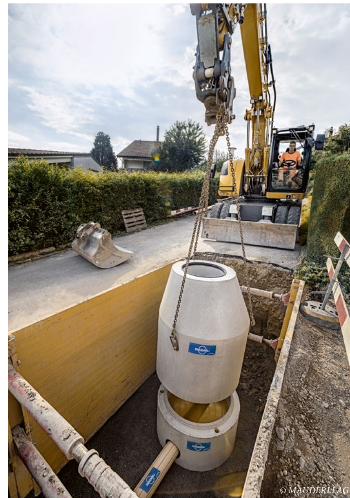
Versetzen eines vorfabrizierten Schachts auf ein Massschachtunterteil
