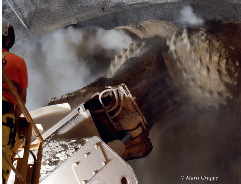
Teilschnittmaschine im Einsatz, Gubristunnel © Marti Gruppe
