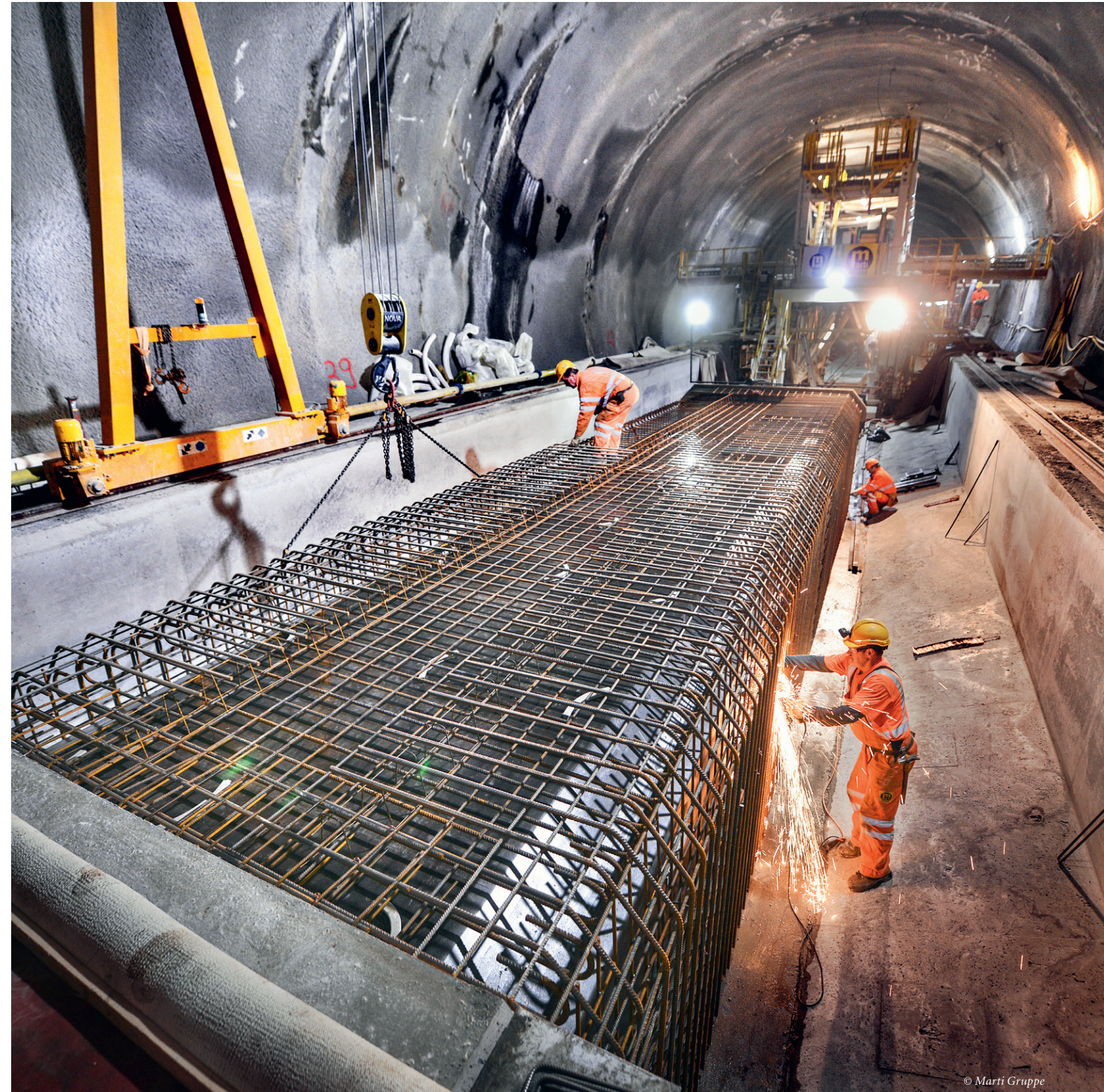
Bewehrung des Werkleitungskanals, Tunnel Court
