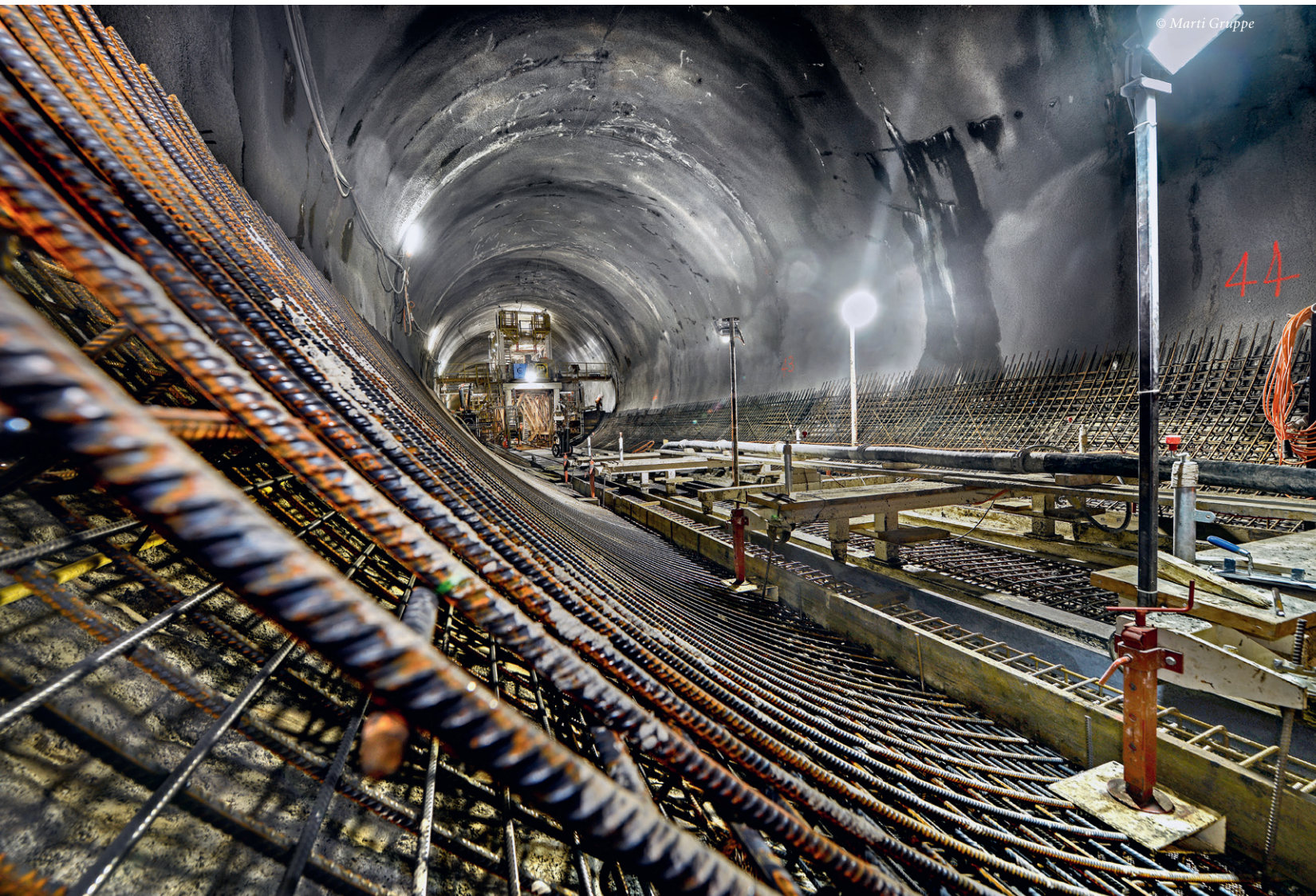
Bewehrung vor dem Betonieren der Innenschale, Tunnel Court
