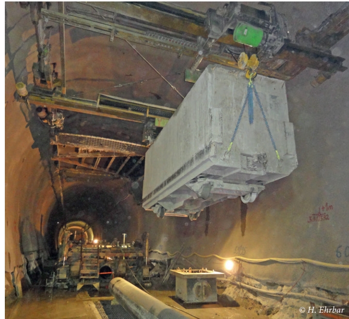
Überbrückung Sohlbaustelle EST Sedrun Süd, Gotthard-Basistunnel
