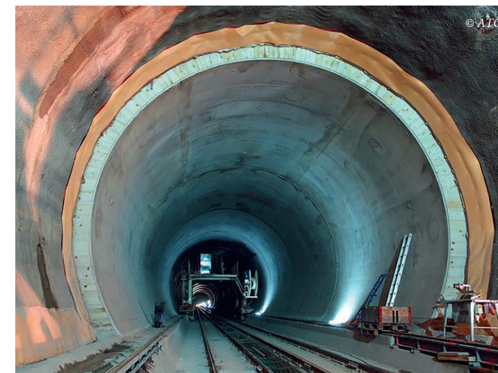
Innenschale, bestehend aus Sohle und Gewölbe (links, Bild: ATG), Schalwagen für Belchentunnel (rechts, Bild: Marti Gruppe)
