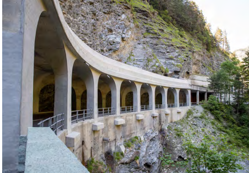
Schutzgalerie auf einer Passstrasse
