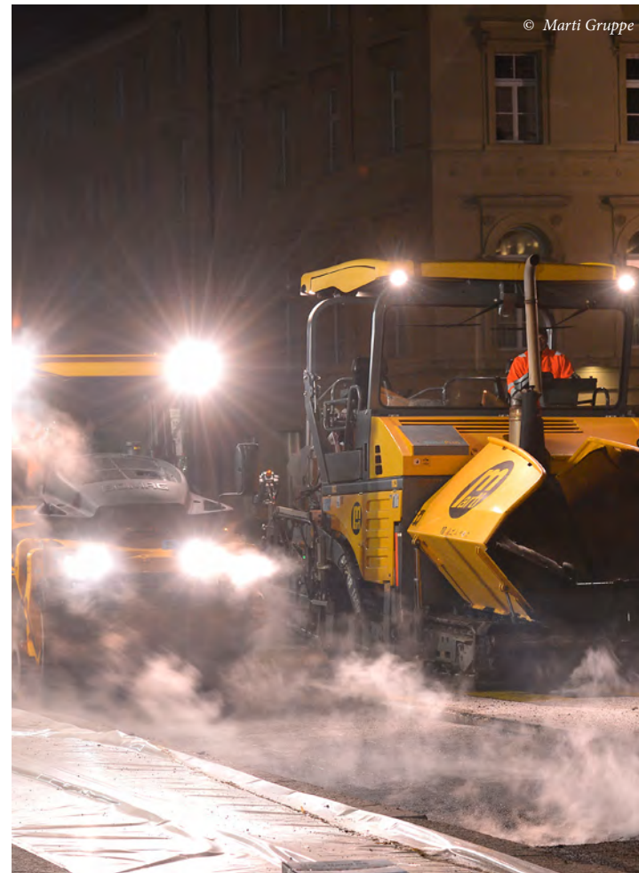
Belagsfertiger mit Doppelvibrationswalze im Einsatz
