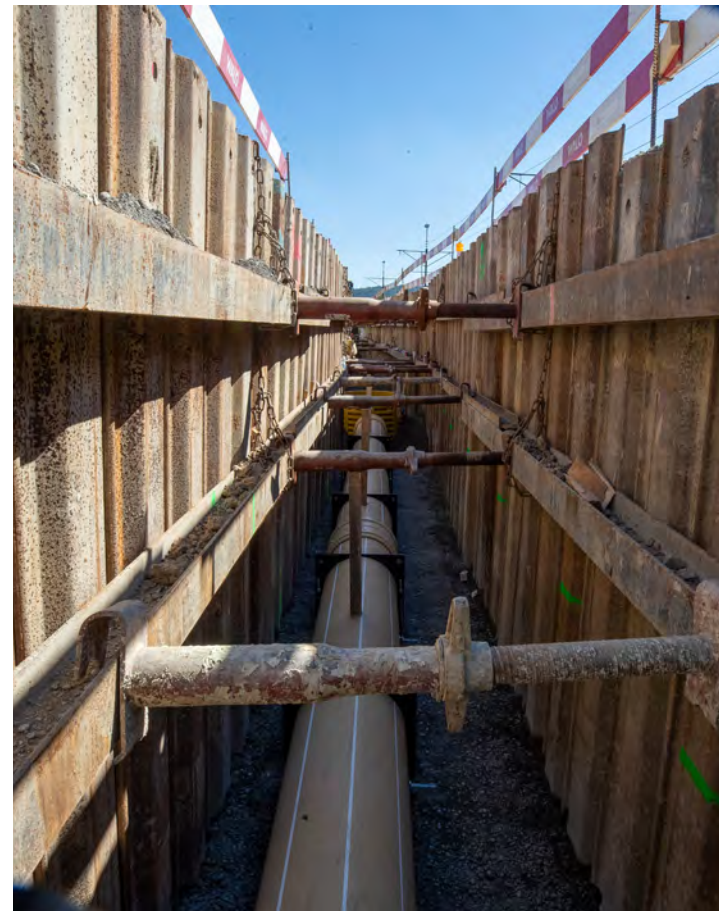
Gespriesster Graben mit verlegter Kanalisationsleitung
