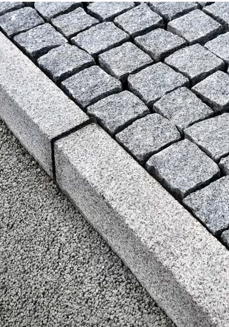
Versetzte Stellplatten mit Natursteinpflästerung vor dem Ausfugen
